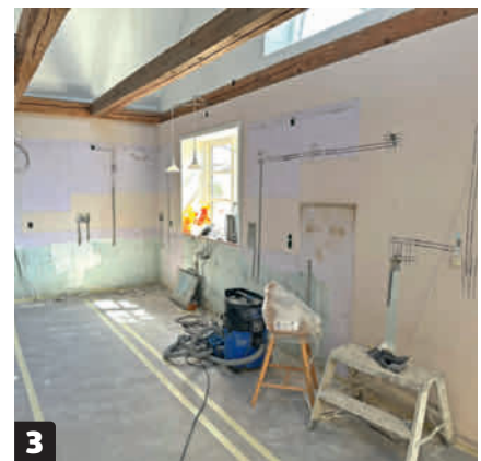
3 Piirrä seinään urien paikat. Uuteen keittiöön ei tule yläkaappeja, joten seinillä on tilaa kohdevaloille. Niiden sähköjohdot upotetaan seinään jyrsittäviin uriin.
