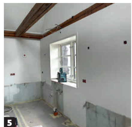
5 Seinät on tapetoitu ja maalattu, ja pisto-rasioiden ja spottien paikat ovat näkyvillä. Nyt voit aloittaa keittiön kokoamisen.
