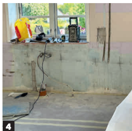
4 Voit jyrsiä urat itse, mutta sähköjohtojen asentamiseen tarvitaan sähköasentaja. Kysy, kuinka syviä roilojen pitää olla.
