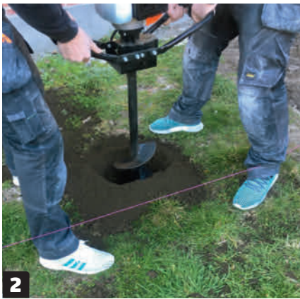
Tee tolppakengille kuopat maakairalla. Niiden pitää olla noin metrin syvyiset. Reiät kannattaa tehdä tarkasti oikeisiin kohtiin, vaikka tolppakenkien paikkaa voikin säätää jonkin verran.
