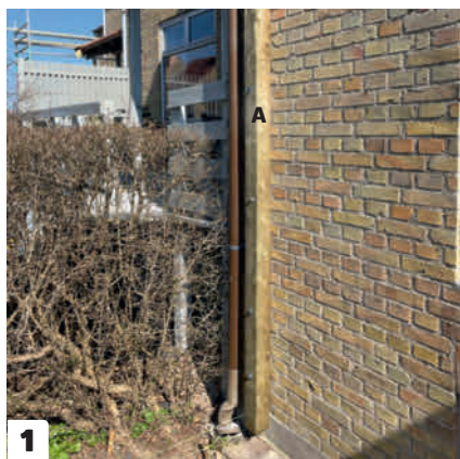
Ruuvaa takimmainen nurkkatolppa (A) kiinni seinään kansiruuveilla valmiiksi porattuihin reikiin. Seinään asennettava tolppa on 180 senttiä pitkä, sillä se toimii myös kaiteen runkona.
