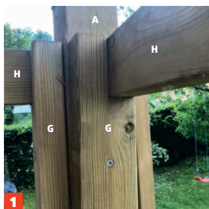
1 Rakenna kaide majan reunoille. Sahaa kahdeksan tolppaa (G), tee niiden päihin lovet ja ruuvaa ne kiinni nurkkatolppiin (A). Sahaa kaiteen ylälankut (H), asenna ne loviin ja ruuvaa ne kiinni.
