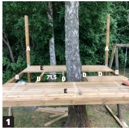
1 Asenna palkit (B) nurkkatolppien (A) väliin. Asenna runkolankut (D) 71,5 sentin välein, jotta saat lattialaudoille (E) hyvän tuen.
