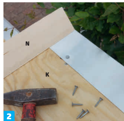
2 Asenna räystäspelti katon (K) alareunaan. Katkaise pelti kulmahiomakoneella ja kiinnitä se 20 millin huopanauloilla. Asenna sivuille ja etureunaan kolmiorimat (M ja N).
