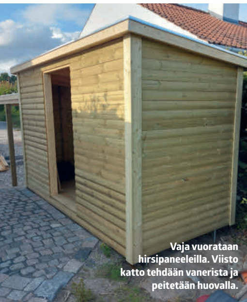
Puurunko on tehty samanlaisista lankuista tolppia ja kattoa myöten.
