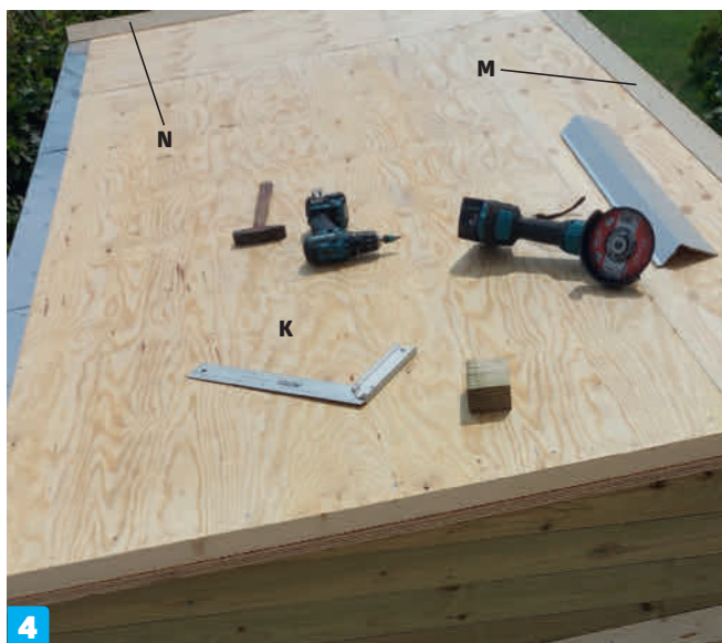
4 Asenna otsalaudat (P) kolmiorimojen (M ja N) ulkopuolelle. Katon alareunaan ei tule otsalautaa, jotta vesi pääsee valumaan alas katolta.
