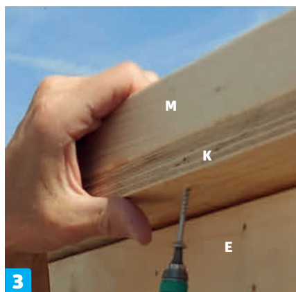
3 Ruuvaa kolmiorimat (M ja N) kiinni alapuolelta 40 millin ruuveilla, jotta yläpuolelle ei jää törröttäviä ruuvinkantoja.
