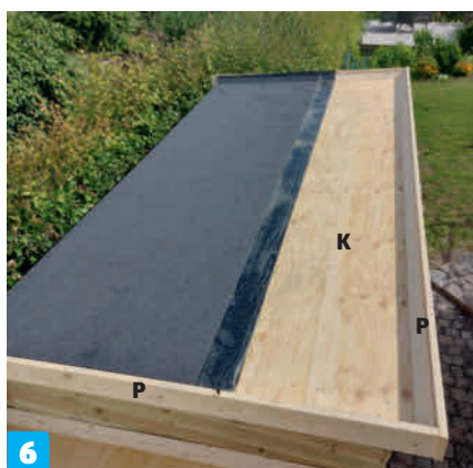
6 Asenna kattuhuopa. Leikkaa huopa niin, että se yltyä otsalautojen (P) päälle. Tässä käytetään kattuhuopaa, jonka ylä- ja alareunassa on 10 sentin liimakaistale. Levitä katon alareunaan kumibitumiliimaa.
