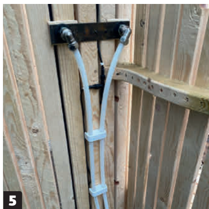
5 Asenna vesiletku suihkun taakse. Muista eristää vesiletkut, jos aiot käyttää suihkua muutenkin kuin kesällä.
