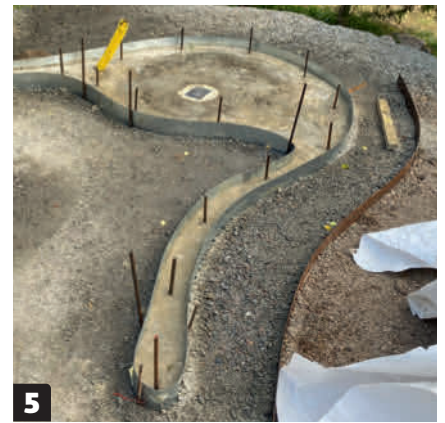
5 Vala perustuksesta mahdollisimman tasainen. Kaato kaivoa kohti tehdään vasta seuraavassa vaiheessa.
