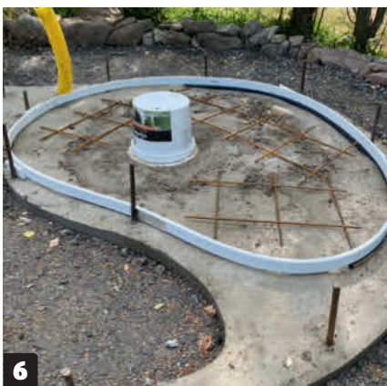
6 Vala suihkun lattia perustuksen päälle. Tee valumuotti muovilistoista ja raudoita lattia 8 millin rauditusverkolla.
