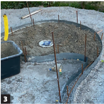
3 Valumuotti tehdään pellistä, jota on helppo taivuttaa. Muotin reunoilla olevat harjateräkset valetaan betoniin.
