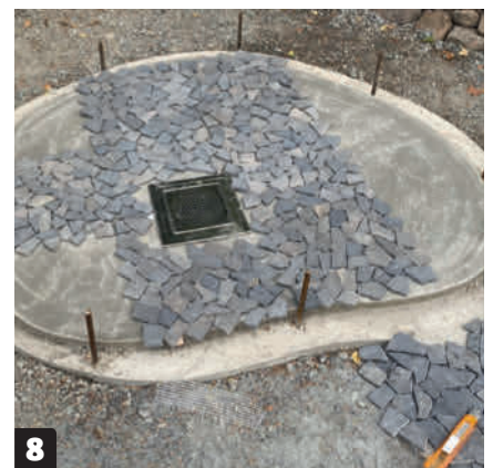
8 Kun pintakerros on kuivunut, sen voi laatoittaa. Levitä betonin päälle aluksi tartuntapohjustetta, jotta laatoituslaasti tarttuu kunnolla kiinni. Käytä pakkasenkestävää laastia.
