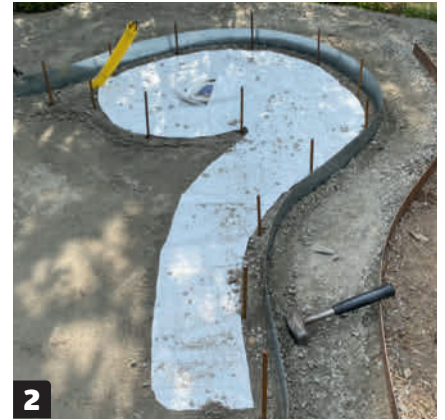
2 Levitä pressu maahan. Kaivo on asennettu jo valmiiksi, joten pressuun tehdään reikä sen kohdalle. Pystytä sapluunan reunoille 10 millin harjateräkset. Seinät yhdistetään myöhemmin harjateräksiin.
