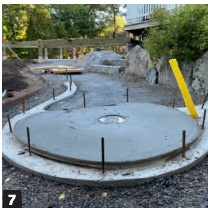
7 Liippaa lattiaan kaato viemäriä kohti. Massaan tulee 1 osa sementtiä, 4 osaa muuraushiekkaa ja vettä. Massan pitää olla melko kuivaa, jotta sitä voi käyttää.
