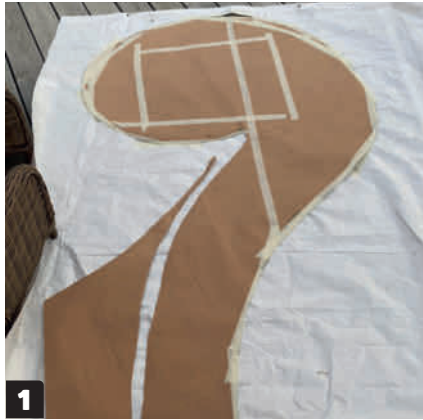
1 Tee aluksi pahvisapluuna perustuksen muodosta. Pane se pressun päälle ja leikkaa muovista samanmuotoinen pala.
