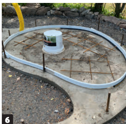
6 Själva duschgolvet gjuts ovanpå själva fundamentet. Den här gången görs en gjutform av böjbara plastlister och så armeras det ännu en gång - den här gången med 8 mm armeringsnät.
