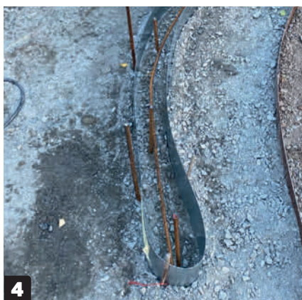
4 Fundamentet armeras så att det inte spricker. Här görs det med 8 mm armeringsjärn. Armeringen ska upp lite, så att den hamnar mitt i betonglagret.
