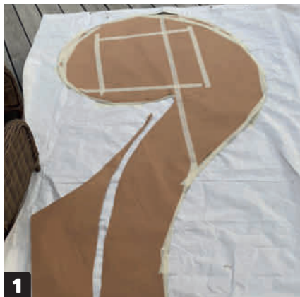
1 Först görs en mall av kartong av fundamentets form som överförs till en presenning, som du kan gjuta av direkt.
