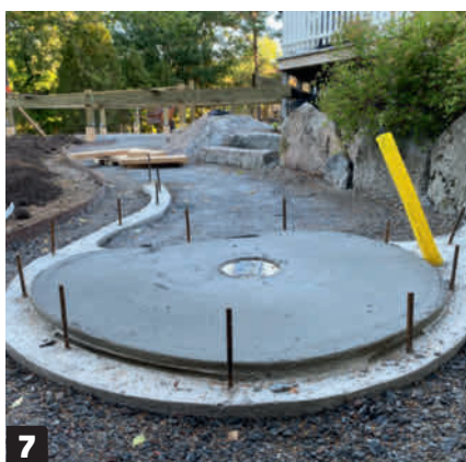
7 Golvet görs som ett putslager så att det går att göra ett korrekt fall mot brunnen. Putslagret består av en betongblandning som ska vara ganska torr så att du kan arbeta med materialet.
