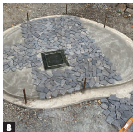
8 När putslagret är torrt kan klinkers läggas, men först är det viktigt att ytan primas så att kakellimet fäster ordentligt. Du måste för övrigt använda ett speciellt lim, som tål frost, när du lägger klinker utomhus.
