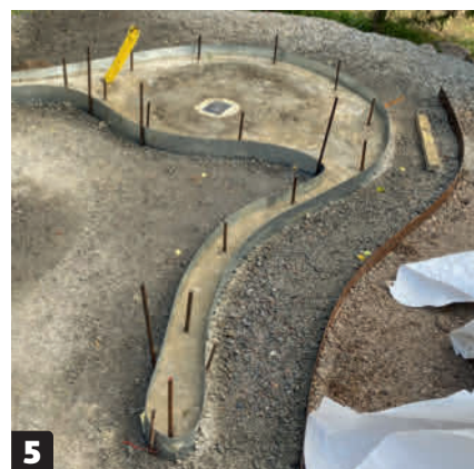
5 Fundamentet gjuts så att ytan blir så jämn som möjligt. Fallet mot brunnen i duschen görs i det efterföljande putslagret.
