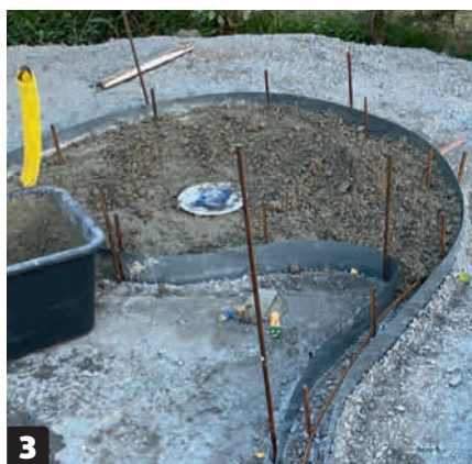
3 Gjutformen består av böjbart stål som är starkt och enkelt kan böjas. Armeringsjärnen, som sitter längs mallens ytterkant, sitter på insidan av gjutformen så att den också gjuts fast.
