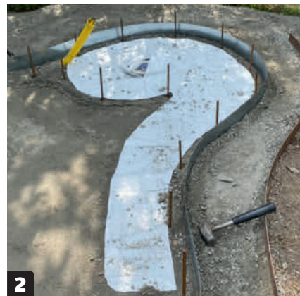
2 Mallen placeras så att den passar med brunnen som redan är på plats. Därefter slås 10 mm armeringsjärn ner längs mallens ytterkant, som ribbväggen senare ska förankras i.
