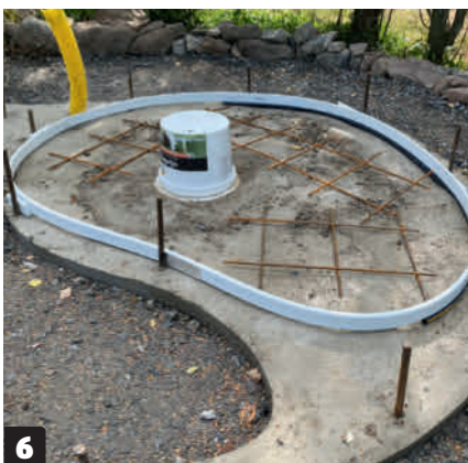
6 Selve dusjgulvet støpes oppå fundamentet. Denne gangen lages det en støpeform av bøyelige plastlister, og det armeres enda en gang – denne gangen med 8 mm armeringsnett.
