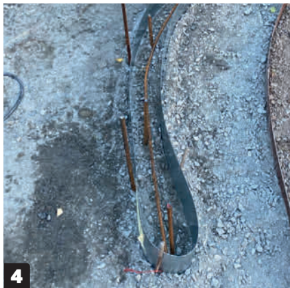
4 Fundamentet skal armeres så det ikke sprekker. Her gjøres det med 8 mm kamstål. Armeringen heves, slik at den ender med å ligge midt i betonglaget.
