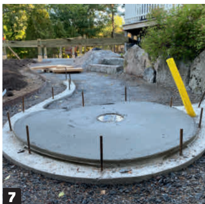
7 Gulvet lages med fall mot sluket. Påstøpen består av 1 del sement, 4 deler 0,4 mm pussesand og vann. Blandingen skal være nokså tørr.
