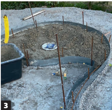
3 Forskalingen lages av bøybart stål. Kamstålet langs ytterkanten av malen sitter på innsiden av forskalingen, slik at også de blir støpt fast.
