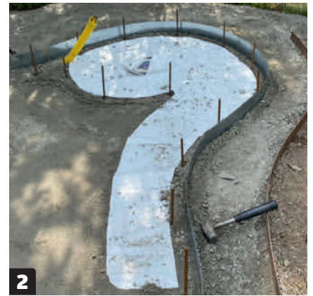
2 Presenningen plasseres slik at den passer med avløpet, som allerede er plassert. Deretter slås det ned spyd av 10 mm kamstål langs ytterkanten av den. Disse skal lekteveggen senere forbindes til.
