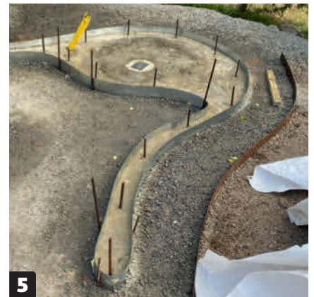
5 Fundamentet støpes slik at overflaten er så plan som mulig. Fallet mot sluket i dusjen lages i det etterfølgende pusslaget.
