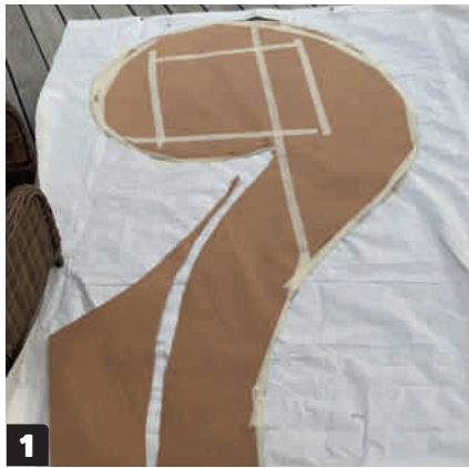
1 Først lages det en pappmal av formen til fundamentet. Malen overføres til en presenning, som det kan støpes oppå.
