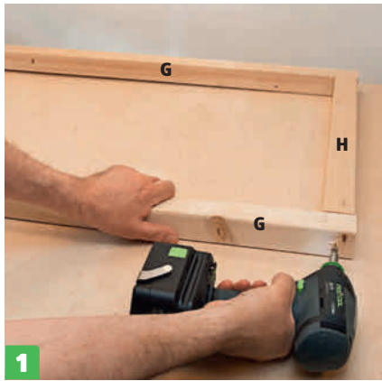
1 Kattoelementti tehdään rimoista (G) ja (H).
