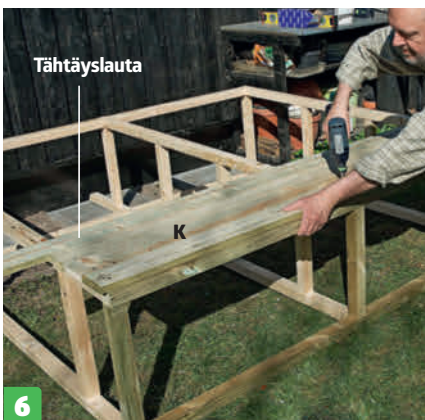
6 Asenna pohjauladat (K ja L) 5x50 millin ruuveilla. Voit asentaa aluksi tähtäyslaudan ja kohdistaa loput laudat sen mukaan.
