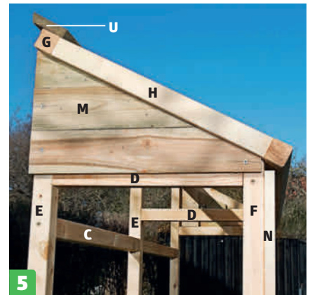
5 Asenna päätykolmiot (M) 5x50 millin ruuveilla. Kolmioihin on helpompia asentaa laudat kuin leikata sopivan muotoiset lasit. Asenna etupuolelle myös rimat (N), jotta voit kiinnittää ikkunoiden kehukset.
