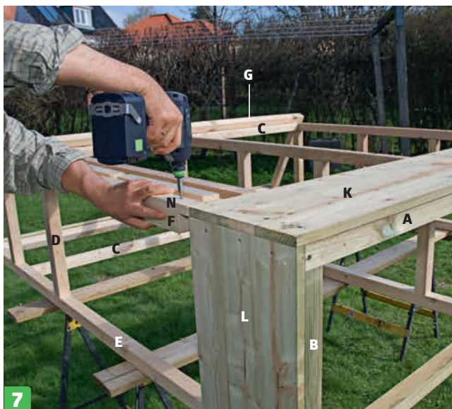
5 Asenna päätykolmiot (M) 5x50 millin ruuveilla. Kolmioihin on helpompia asentaa laudat kuin leikata sopivan muotoiset lasit. Asenna etupuolelle myös rimat (N), jotta voit kiinnittää ikkunoiden kehukset.
