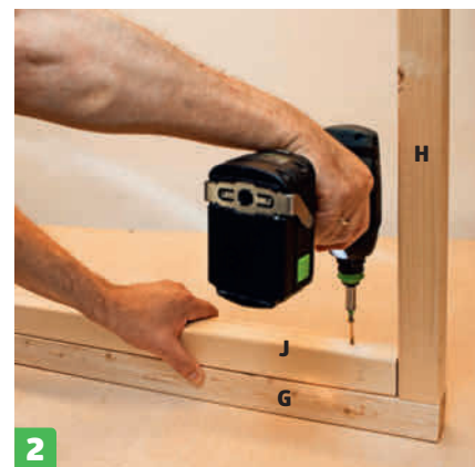
2 Skru fast toppstykket (J) på innsiden av takrammen. Skru den først fast i G, og skru deretter en skrue på hver side gjennom H.
