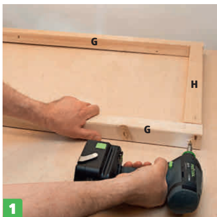
1 Takrammen med langsider (G) og endestykker (H) settes sammen. Alle deler kappes til i lengde og skrues sammen med 5 x 60 mm skruer i hjørnene.
