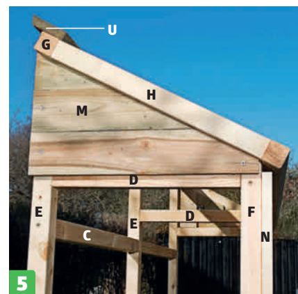
5 Skru fast de skrå sidene (M) øverst med 5 x 50 mm skruer. Det er enklest å tette igjen her i stedet for å sette inn glass. Monter også listene (N) som vindusrammene skal festes til i fronten.
