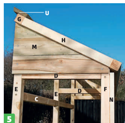
5 Monter de skrå sider (M) foroven med 5 x 50 mm skruer. Det er lettest at lukke af her frem for at sætte glas i. Monter også listerne (N) på forsiden, som vinduesrammerne skal gøres fast til.
