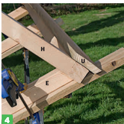
4 Sav brættet U til, og monter til tagrammen. Lav et skråt snit på 30 grader, så det kommer til at flugte med den væg, drivhuset skal stå op ad. Brættet (U) skal bruges til at fastgøre tagvinduesrammen til.
