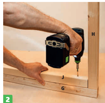
2 Skru topstykket (J) fast på indersiden af tagrammen. Skru den først fast til G, og giv den derefter en skrue i hver side gennem H.
