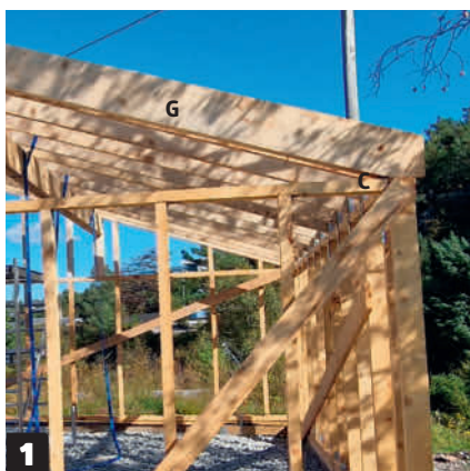
1 Nosta vaarnapalkit (G) yläpalkkien (C) päälle. Sahaa vaarnapalkkien päät aluksi poikki seinien suuntaisesti. Kohdista palkit runkotolppien kohdalle.
