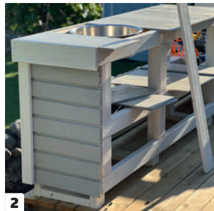
2 Asenna nurkkalaudat. Keittiön ulkonurkkiin asennetaan valkoiset laudat niin, että toinen lauta tulee toisen reunan päälle.
