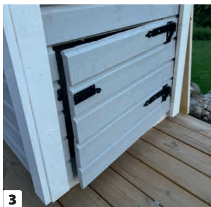
3 Kulmaelementissä on luukku, jonka takana on tilaa kaasupullolle. Ovi tehdään sahaamalla laudat poikki ja asentamalla niihin saranat ja työntösälpä.
