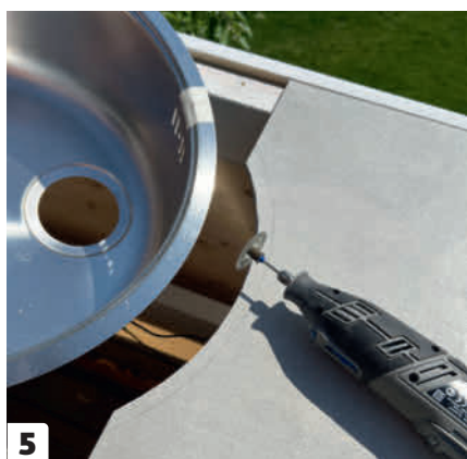
5 Saha reikä tiskialtaalle. Tässä käytetään pyöreää allasta. Saha neljään laattaan sopiva aukko esimerkiksi Dremelillä ja pienellä kiviterällä.
