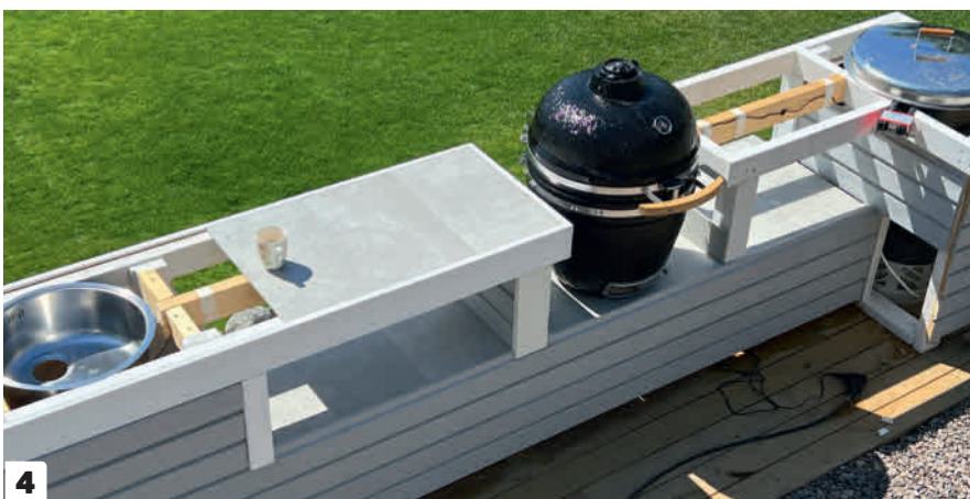
4 Tee pöytälevy laatoista. Asenna aluksi laudat korkeiden pöytien reunaan siten, että lautojen pinta nousee laatan paksuuden verran elementtien yläpuolelle. Sen jälkeen voit leikata laatat niin, että ne sopivat lautareunusten sisään ja saavat tukea elementtien ylärimoista.
