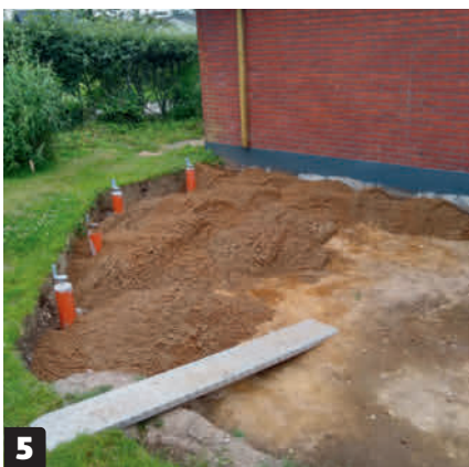
5 Levitä kuoppaan noin 15 sentin kerros mursketta ja tasoita se niin, että pinta kallistuu noin sentin metrin matkalla. Tiivistä murske tärylevyllä ja levitä päälle 3–5 sentin kerros asennushiekkaa.
