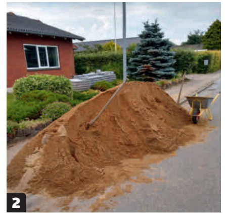
2 Tilaa sopiva määrä asennushiekkaa ja mursketta ja pidä huoli, että ne tuodaan mahdollisimman lähelle terassia. Mitä lähempänä ne ovat, sitä lyhyempiä matkoja joudut tekemään kottikärryjen kanssa.
