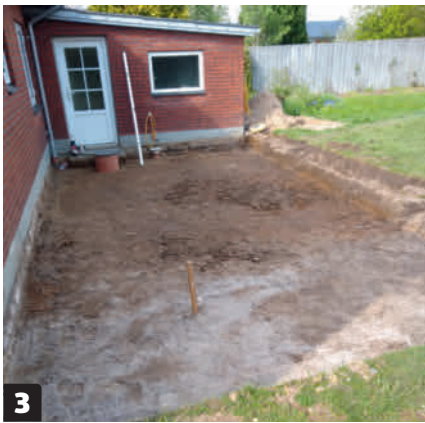
3 Kaiva kuoppa minikaivurilla. Kuopasta tehdään noin 26 senttiä syvä, jotta siihen mahtuu mursketta, asennushiekkaa ja kartanokiviä. Maa painuu noin sentin, kun se tiivistetään tärylevyllä.
