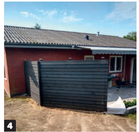
4 Ruuvaa nurkkalista kiinni, kun kaikki ulkovuorilaudat ovat paikoillaan. Asenna lopuksi galvanoidut tolpanhatut.
