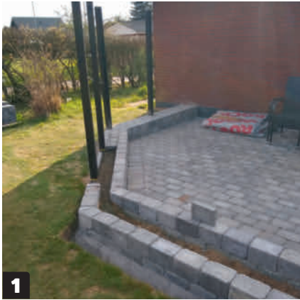
1 Ruuvaa tolpat (D) kiinni tolppakenkiin.
