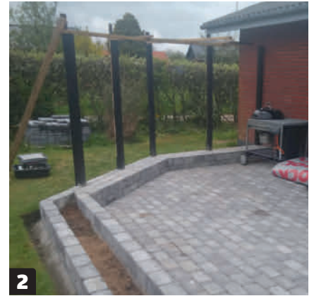
2 Ruuvaa pari rimaa (E) tolppien (D) päihin, jotta tolpat pysyvät suorassa ulkovuorilautojen asentamisen ajan.
