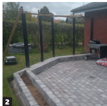
2 Skru fast et par lekter (E) mellom stolpene (D), slik at det passer med ønsket avstand mellom stolpene. Dette sikrer at stolpene har lik avstand i topp og bunn.
