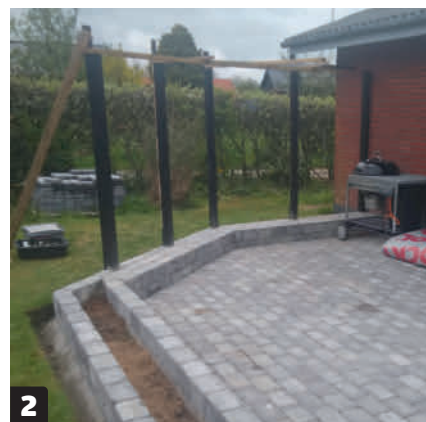
2 Skru et par lægter (E) fast mellem stolperne (D), så det passer med den ønskede afstand mellem stolperne. På den måde sikrer du dig, at der er lige langt mellem stolperne foroven som forneden.
