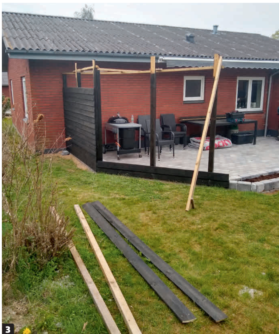
3 Skru klinkbrædderne fast. Start med det nederste, og giv hvert bræt en skrue pr. stolpe. I vores tilfælde giver det altså tre skrue pr. bræt. Skruen monteres ca. 3 cm oppe i forhold til brættets underkant. På den måde holder hvert bræt fast på overkanten af brættet nedenunder.
