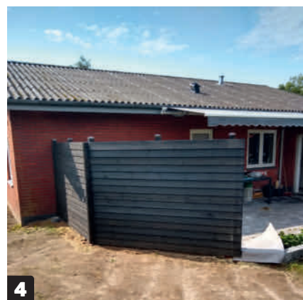
4 Skru hjørneprofilen fast, når du har monteret alle beklædningsbrædderne. Til sidst monteres de galvaniserede stolpehatte.
