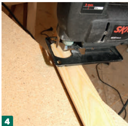
4 Ofta behöver stegen förnyas på framkanten vilket vi måste göra här på det översta trappsteget. Här gör vi det med en 8 x 43 mm hyvlad list som vi kapar i rätt längd.
