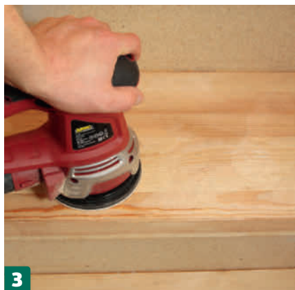
3 De större ytorna slipas med en excenter-slip. Börja med korn 40 och när all lack och alla ojämnheter är borta, använd finare och finare sandpapper på båda slipmaskinerna tills stegen är silkeslena.
