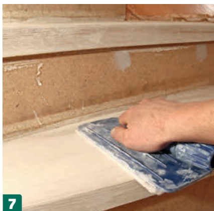
7 Efter åtta timmar slipas den torra vita ytan med en slipmatta eller sandpapper korn 120. Dammsug noggrant.
