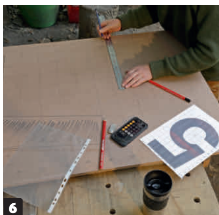
6 Marker sentrum av 5-tallets "mage" på MDF-platen. Her må du støtte deg til kvadratnettet for å få riktige proporsjoner. Dermed har du kompassrosens senter.
