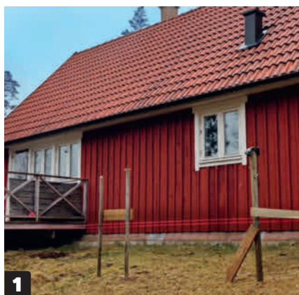
1 Tillbyggnadens yttre mått markeras med så kallade profiler. Profilerna placeras i hörnen så att ett snöre kan spännas mellan dem, vilket anger fundamentets bredd och höjd.
