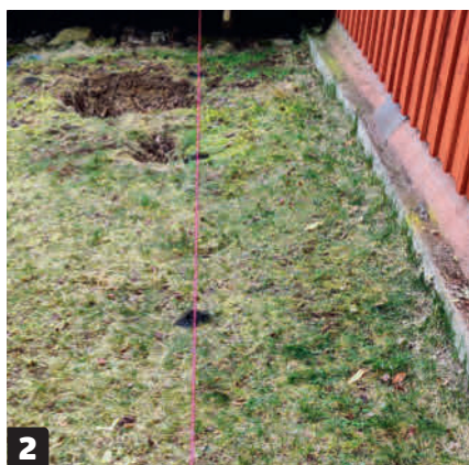
2 Här ska fundamentet bestå av ett bjälklag. Till att börja med måste därför en serie punktfundament göras för att ha något att fästa syllarna i.
