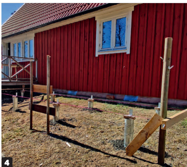
1 Tillbyggnadens yttre mått markeras med så kallade profiler. Profilerna placeras i hörnen så att ett snöre kan spännas mellan dem, vilket anger fundamentets bredd och höjd.
