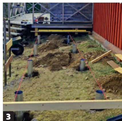
3 Punktfundamenten är lätta att göra själv. Här används ventilationsrör som "gjutform". Hålen görs och rören sätts efter ett snöre.
