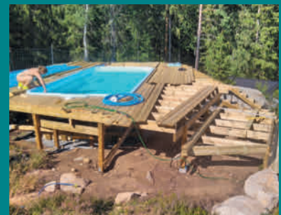
Terassi on tuettu monesta kohdasta, jotta se pysyy suorana.
