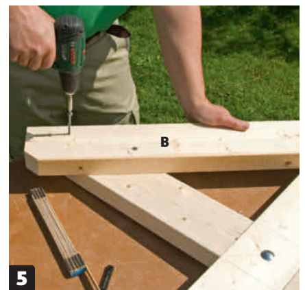
5 Ruuvaa poikkipuu (B) jalkoihin (A) parilla 6x80 millin ruuveilla molemmilta puolilta. Tarkista aluksi, että ne ovat suorassa kulmassa.
