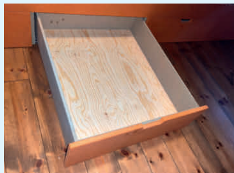
Under køjesengen er der tre skuffer med god opbevaringsplads, bygget af MDF og krydsfiner.
