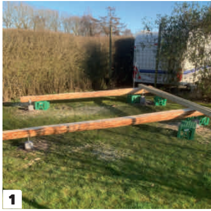
1 Asenna aluksi pitkien seinien alapelkat tolppakiviin. Hirsiiin pitää tehdä lovet.
