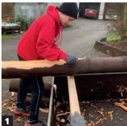
1 Kuori rungot. Parkkuurautaa vedetään itseä kohti viistossa kulmassa. Puusta poistetaan vain uloin kuori.
