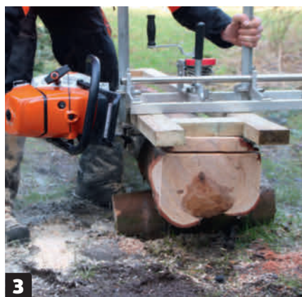
3 Rungot sahataan suoriksi toiselta puolelta. Tässä käytetään sahausohjainta, jossa on teline pitkälaippaista moottorisahaa varten.
