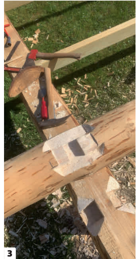
3 Hirret liitetään toisiinsa nurkissa salvoksilla, jotka tehdään kirveellä ja taltalla. Tarkoitus on tehdä kaksi tappia, joista toinen on iso ja toinen pieni. Iso tappi on neliökulmio, joka sopii vastaavaan koloon. Pieni tappi on viisto ja sopii viisteisessä hirressä olevaan viistoon loveen. Kun hirret liitetään yhteen, rakenne lukittuu tehokkaasti ja liitoksesta tulee vahvempi siihen verrattuna, että hirret liitettäisiin yhteen pelkästään loveamalla. Voit kuitenkin tehdä niin, jos salvokset tuntuvat liian monimutkaiselta.
