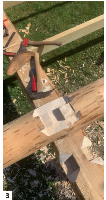
3 Vi låser stockarna i varandra i hörnen med en fog som görs med hjälp av en yxa och ett stämjärn. Tanken är att man ska göra två tappar, en stor och en liten. Den stora tappan är kvadratisk och passar in i ett motsvarande hål. Den lilla tappan är diagonal och passar in i en vinklad utstämning i den motsatta stocken. När de två stockarna sätts ihop låses konstruktionen effektivt och fogen blir starkare än om du bara hade gjort en tappfog (men gör det, om det här verkar för komplicerat).
