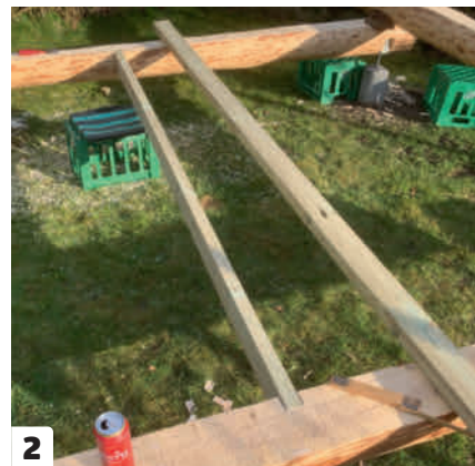
2 Gulvbjelkene stemmes inn i stokkene.
