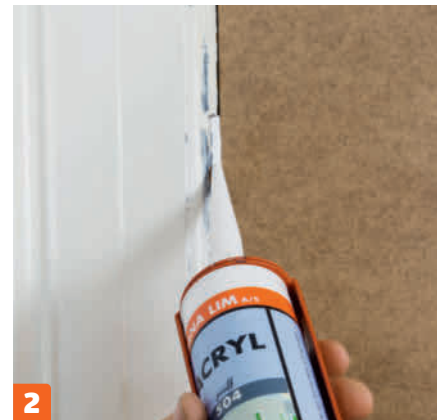
2 Täta alla fogar med akrylfogmassa. Det ger både en snygg finish och en effektiv ljudisolering. Ljudet letar sig in genom varje hål och springa.
