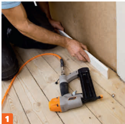
1 Fäst en golvlist på båda sidor om dörren - med dyckert eller stift var 20:e cm. Här använder vi en färdigmålad list. På så sätt sparar vi in det första lagret färg. Dyckerten spacklas över före den sista strykningen.
