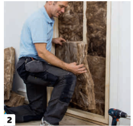
2 Sätt isoleringen på plats. Isoleringen ska sitta stramt, men får inte pressas ihop, annars förlorar den sina isolerande egenskaper. Sätt även en MDF-skiva på den andra sidan.
