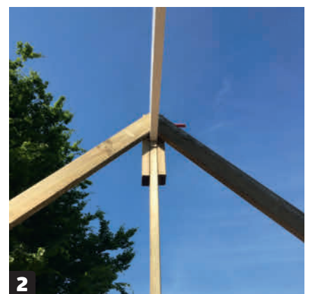
2 Kurkihirsi tuetaan väliaikaisesti kahdella lankunpätkällä, jotta se ei kaadu vaarnapalkkien asentamisen aikana.
