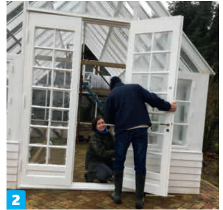
2 Ikkunat ja ovet ostettiin etukäteen, joten runko on mitoitettu niiden mukaan eikä toisinpäin kuten tavallisesti.
