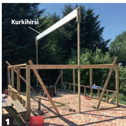
1 Vaarnapalkit asennetaan kurkihirren kylkeen ja seinien yläpalkkien päälle. Kurkihirsi kiinnitetään kasvihuoneen päissä oleviin tolppiin.
