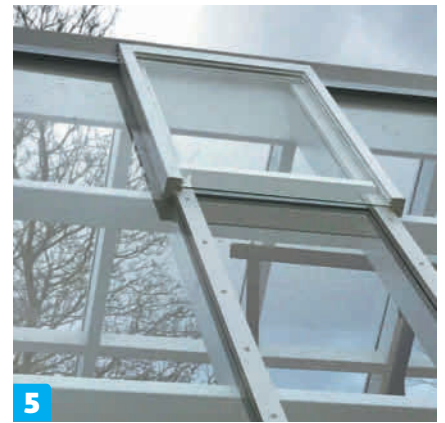
5 Katossa on muutama kääntöikkuna, jotta kasvihuonetta voi tuulettaa. Ikkunat on kiinnitetty kurkikirteen saranoidella. Ikkunat ovat tiiviitä, koska ne ulottuvat viereisten pintojen päälle.
