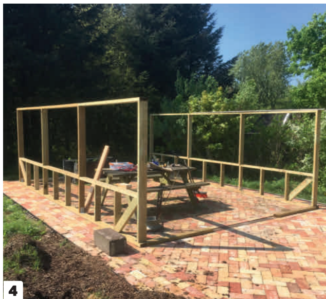
2 Kun alaohjauspuu on suorassa, runkotolpat on helppo asentaa. Tässä ne asennetaan 180 sentin välein ikkunoiden takia. Lankut kiinnitetään alaohjauspuuhun 80x80 millin kulmarautoilla.
