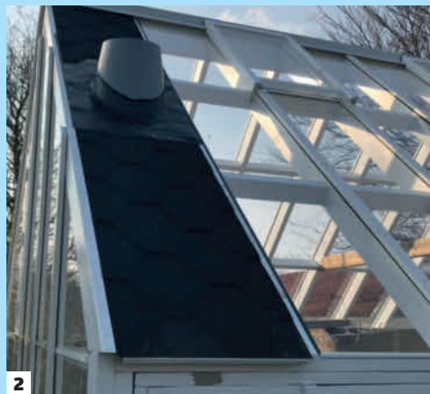
1 Reunimmaiseen palkinväliin tehdään kiinteä katto vanerista ja kattohuovasta. 2 Katon läpi asennetaan savupiippu. Muista eristää piippu hyvin, jotta se ei sytytä kattoa palamaan. 3 Takka lämmittää kasvihuonetta ja pidentää sen käyttöaikaa merkittävästi.
