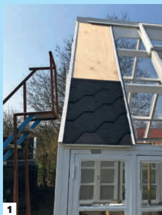
1 Reunimmaiseen palkinväliin tehdään kiinteä katto vanerista ja kattohuovasta. 2 Katon läpi asennetaan savupiippu. Muista eristää piippu hyvin, jotta se ei sytytä kattoa palamaan. 3 Takka lämmittää kasvihuonetta ja pidentää sen käyttöaikaa merkittävästi.
