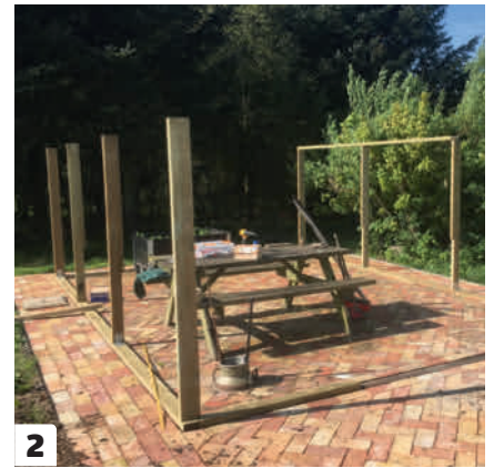
2 Kun alaohjauspuu on suorassa, runkotolpat on helppo asentaa. Tässä ne asennetaan 180 sentin välein ikkunoiden takia. Lankut kiinnitetään alaohjauspuuhun 80x80 millin kulmarautoilla.
