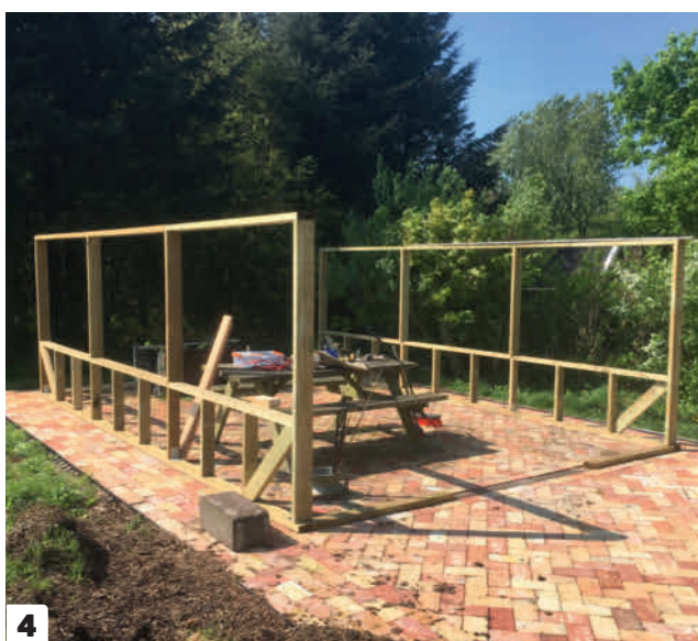
2 När syllarna har rätats upp går det snabbt med stommens lodräta regler. De ska stå med max 180 cm mellanrum. Reglarna fästs i syllerna med 80 x 80 mm vinkelbeslag, ett på varje sida.
