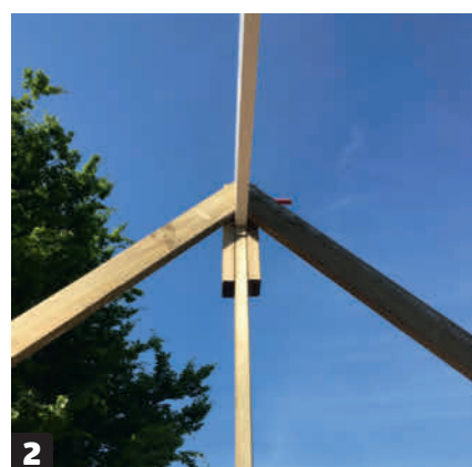
2 Nockregeln understöts tillfälligt med två regelbitar överst, så att den inte välter när takstolsbenen monteras.
