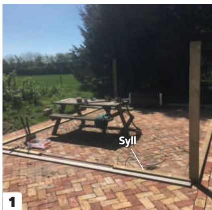
1 Ovanpå bottenramen, som det nu ligger beläggning runt, ska läggas en syll. Syllerna ska rätas in så att den är rak och rätas upp så att den är vågrät.
