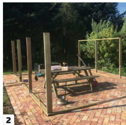
2 När syllarna har rätats upp går det snabbt med stommens lodräta regler. De ska stå med max 180 cm mellanrum. Reglarna fästs i syllerna med 80 x 80 mm vinkelbeslag, ett på varje sida.
