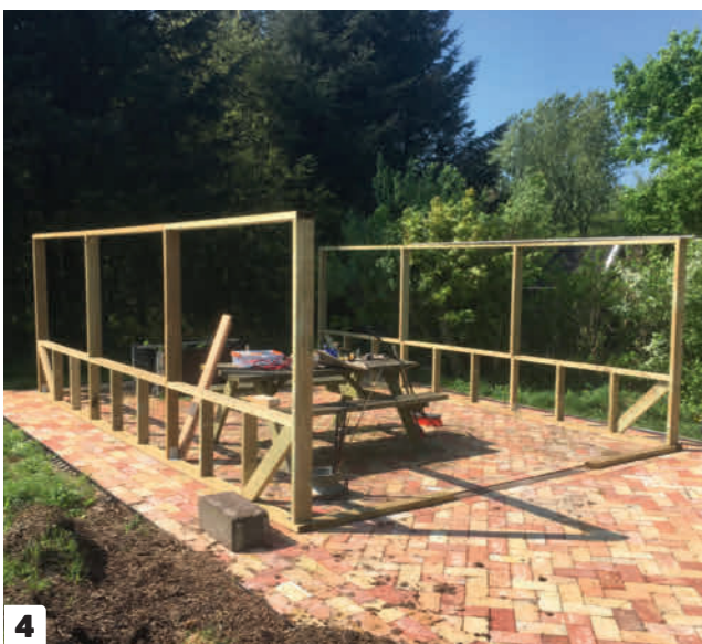
2 Når bundremmen er rettet op, er de lodrette reglar til skelettet hurtigt klar. De skal stå med maks. 180 cm mellemrum. Reglarne fastgøres til bundremmen med 80 x 80 mm vinkler, én på hver side.
