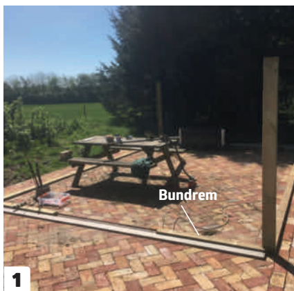
1 Oven på bundrammen, som der nu er belægning omkring, skal der laves en bundrem. Remmen skal rettes ind, så den er lige, og rettes op, så den er vandret.
