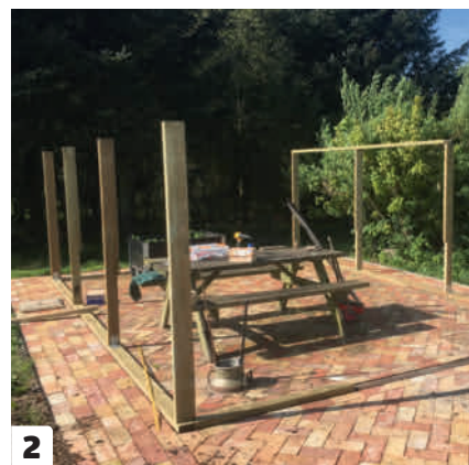
2 Når bundremmen er rettet op, er de lodrette reglar til skelettet hurtigt klar. De skal stå med maks. 180 cm mellemrum. Reglarne fastgøres til bundremmen med 80 x 80 mm vinkler, én på hver side.
