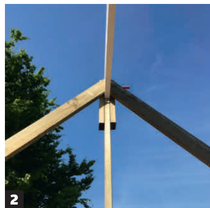
2 Kippbjælken understøttes midlertidigt med to reglarstumper i toppen, så den ikke vælter, mens spærne monteres.
