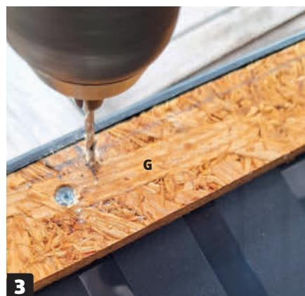
**Forbor til skrukroker.** Bor tre 2,5 mm hull. To bores 4 cm fra hver ende av avstiverne (G). Et tilsvarende hull bores cirka midt på avstiverne. Sørg for at hullene sitter med samme avstand til toppen av avstiveren.
