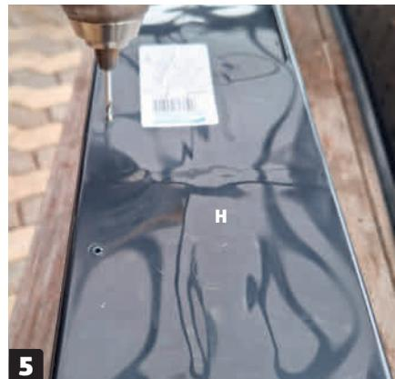
**Bor hull til drenering i to altankasser (H).** På undersiden av de to altankassene, som skal henge øverst, skal det bores 3-4 mm dreneringshull langs forkanten. Hullene skal sitte med cirka 10 cm avstand.
