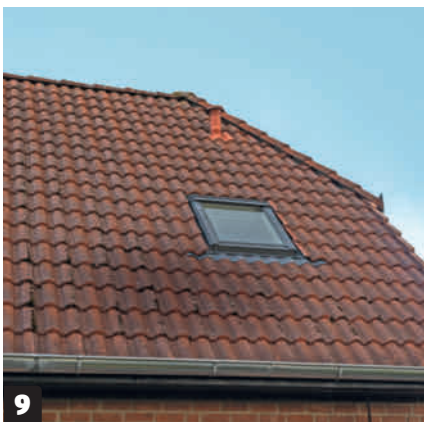
9 K kaikki on valmista. Kun viimeiset tiilet ovat paikoillaan, voit jatkaa yläkerran remonttia. Sisään tulee nyt paljon valoa mutta ei pisaraakaan vettä.
