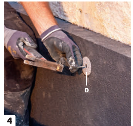
4 Paina kiinnike reikään. Jos reiässä on liikaa pölyä, se pitää poistaa, jotta kiinnike mahtuu paikalleen. Asenna ruuvi vasta, kun kaulus on levyä vasten, jotta tulppa ei juutu kiinni.
