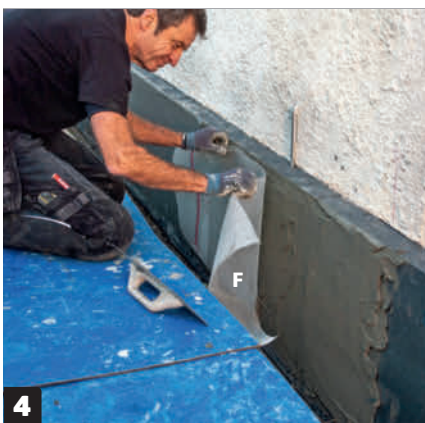
4 Paina rappausverkko (F) varovasti märkään laastiin. Asenna verkko niin päin, etteivät sen reunat taivu ulospäin ja irtoa laastista.
