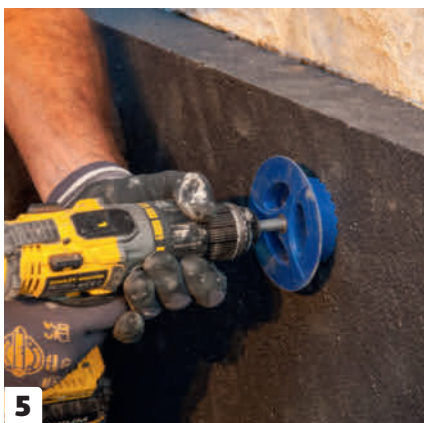
5 Väännä ruuvi pohjaan asennustyökälulla. Kun leveä reunus on levyn pinnalla, kaulus on pohjassa, ja voit asentaa tulpan (E).
