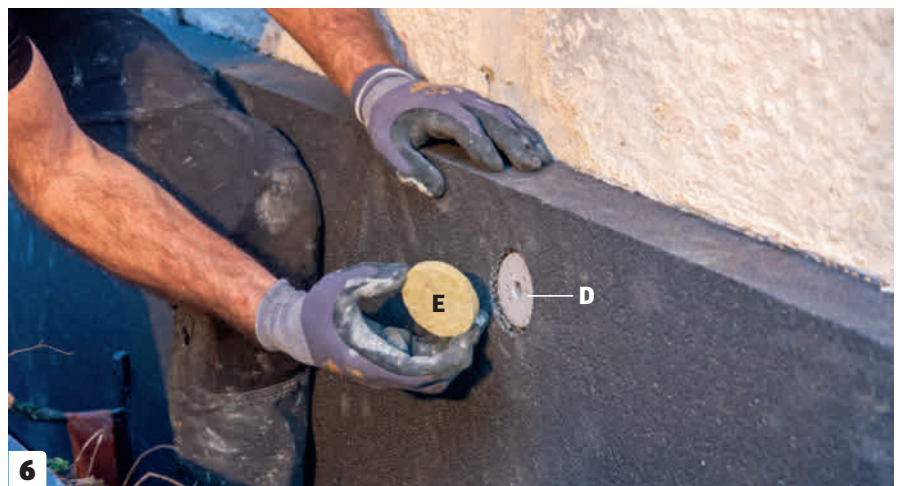
6 Kiinnike (D) peitetään villatulpalla (E). Sen tarkoitus on pitää metallikiinnikkeet pinnan alla ja estää niitä erottumasta rappauksen läpi.
