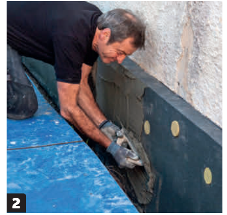
2 Levitä rappauslaasti (H) eristelevyille (A) teräslastalla yhden tai kahden verkon (F) kohdalle kerrallaan. Pyri tekemään kerroksesta 8–10 milliiä paksu.
