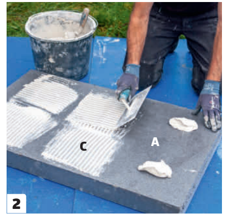
2 Levitä laastia (C) eristelevyjien (A) taakse 8–10 millin laastikammalla. Levyjä ei saa liimata kiinni toisiinsa edes nurkissa.
