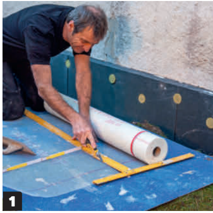
1 Leikkaa lasikuituverkosta (F) sopivia paloja ja sekoita laasti. Tässä tapauksessa sokkelin yläosa rapataan 45–50 sentin korkeudelta, joten verkosta leikataan 45 sentin levyisiä paloja.
