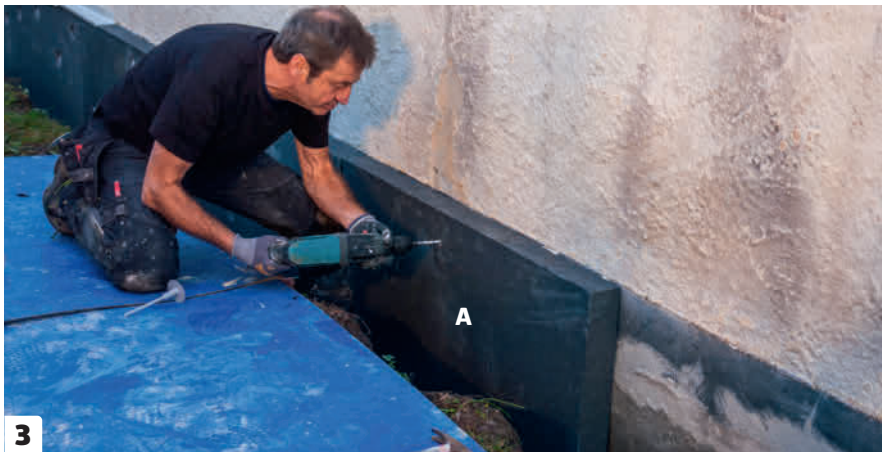
3 Paina eristelevyt (A) paikoilleen niin, että niiden yläreunasta tulee tarkasti vaakasuora. Poraa reiät kiinnikkeille (D) 8 millin terällä ja poravasaralla. Kiinnikkeet asennetaan maan pinnan yläpuolelle. Kiinnikkeet asennetaan levyn keskelle ja saumojen lähelle. Tee rei'istä syvät, sillä porauspölyä on vaikea saada kokonaan pois rei'istä.
