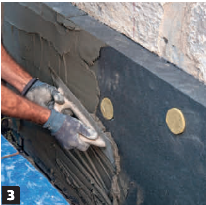
3 Tasoita laasti (H) teräslastalla. Mitä sileämpi pinta on, sitä helpompi verkko (F) on painaa laastiin. Voit tarkistaa paksuuden upottamalla lastan nurkan laastiin.
