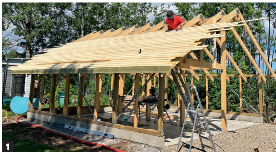
Aluskate tehdään raakaponttilaudoista (J). Ne on helppo asentaa ja naulata kiinni runkonaulaimella. Voit asentaa alaräystään otsalaudat jo ennen raakaponttia.
