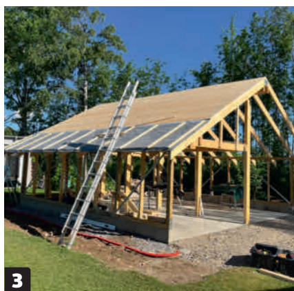
Peltikatolle tarvitaan aluskate. Sen ei tarvitse olla kiinteä kuten tässä, sillä pelkät ruuteet ja aluskatemuovi riittävät. Raakapontin päälle asennetaan diffuusioavoin aluskatemuovi, joka ei kerää kosteutta.
