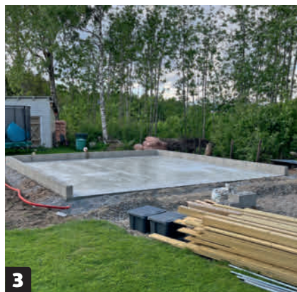
3 Rakenna sokkeli lecaharkkoista , kun betonin päällä voi kävellä. Tee sokkelista tarkasti suorakulmainen ja vaakasuora.
