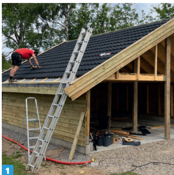
Peltikatolle tarvitaan aluskate. Sen ei tarvitse olla kiinteä kuten tässä, sillä pelkät ruuteet ja aluskatemuovi riittävät. Raakapontin päälle asennetaan diffuusioavoin aluskatemuovi, joka ei kerää kosteutta.
