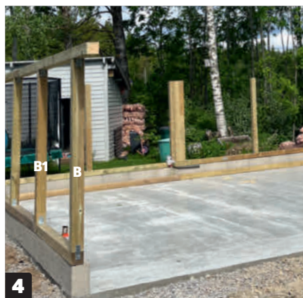
4 Autokatoksen runko rakennetaan painekyllästetyistä 100x100 millin tolpi (B) ja 50x100 millin lankuista (B1). Asenna huopaa sokkelin ja alaohjauspuun väliin ja kiinnitä tolpat karmiruuveilla.
