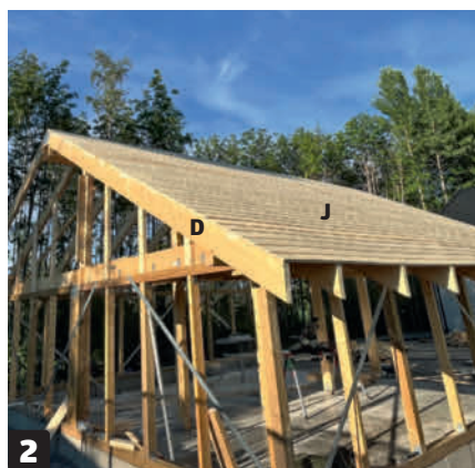
Asenna laudat (J) ylipitkinä ja sahaa ne poikki lopuksi upotussahalla tai käsisirkkelillä.
