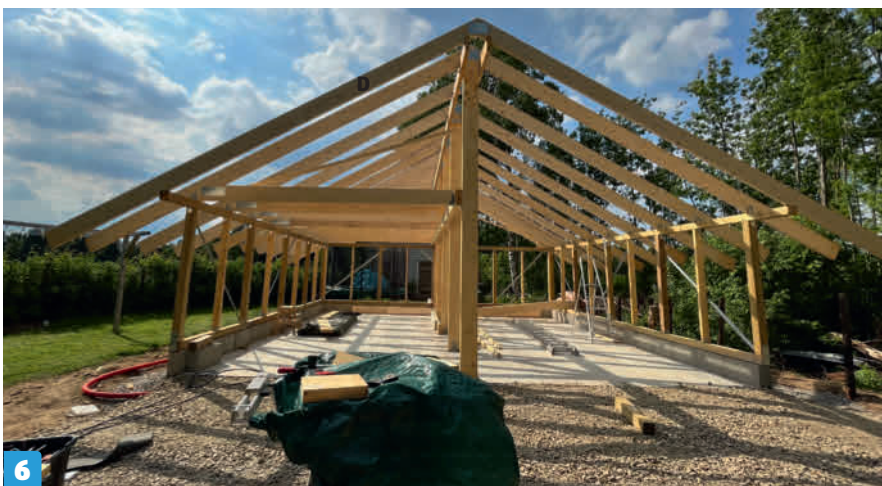
Sahaa ensimmäinen vaarnapalkki (D) ja tarkista, että se on oikean pituinen ja sopii autokatoksen kumpaankin päähän. Jos mitta heittää enemmän kuin muutaman millin, oikaise runkoa, jotta rakennuksesta tulee suora ja katon tekeminen sujuu helposti.
