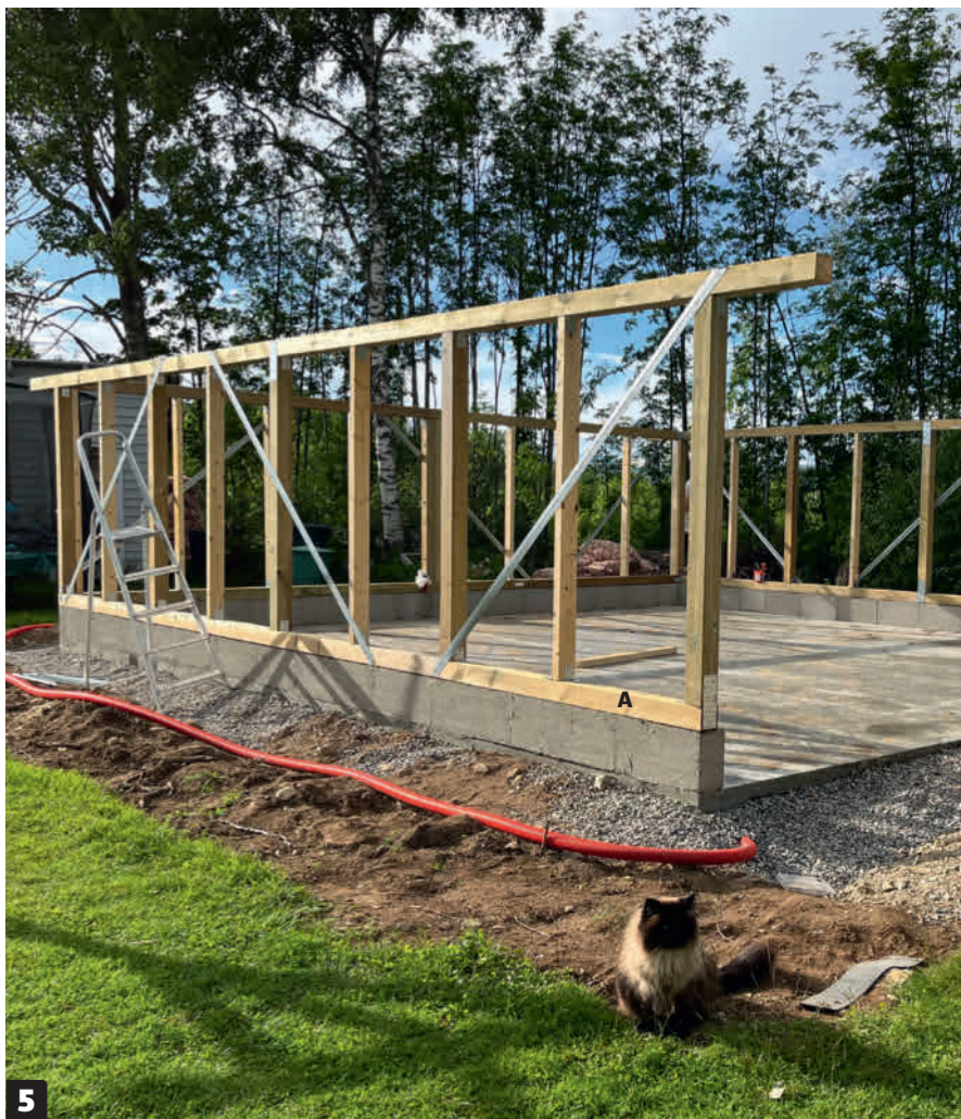
5 Asenna ensimmäiseksi alaohjauspuu (A). Rungon rakentaminen sujuu helposti, kun asennat alaohjauspuun tarkasti vaakasuoraan ja sahaat kaikki tolpat valmiiksi maassa. Piirrä tolppien paikat alaohjauspuuhun ja kiinnitä kulmaraudat niiden viereen, jotta voit ruuvata tolpat nopeasti kiinni. Sen jälkeen voit asentaa yläpalkit ja jäykistää rungon sidevanteilla.
