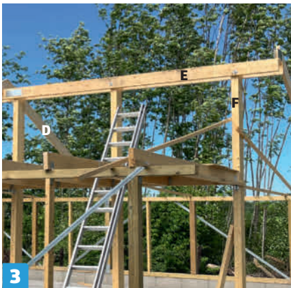
Kantavien keskitolppien (F) päälle pultataan harjapalkit (E). Niiden päälle asennetaan vaarnapalkit (D), joten harjapalkkien pitää olla tarkasti vaakasuorassa.
