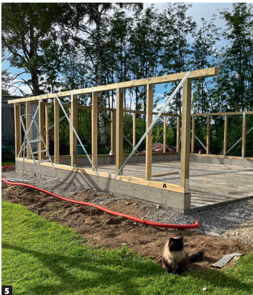
5 Räta först upp syllen (A). Om syllen är 100% horisontell är det mycket enklare att bygga stommen eftersom du kan kapa alla stående reglar lika långa. Rikta sedan in de stående stolparna och reglarna på syllen och placera ett vinkeljärn bredvid var och en av dem så att de enkelt kan lodas och skruvas fast. Därefter kan hammarbandet monteras innan du slutligen förstärker alltihop med vinddragband.
