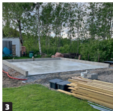
3 Bygg en sockel av lecablock när betongen går att gå på. Stenarna sätts med lim och här kan eventuella ojämnheter från gjutningen jämnas till så att sockeln blir helt vinkelrät.
