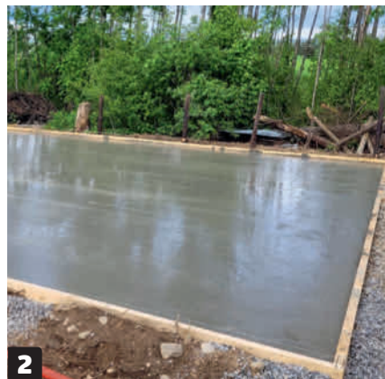
2 Lag en forskaling som kapsler inn betongplaten. Forskalingen må være stivet opp slik at betongen ikke skyver den ut av form. Her støpes platen med en ferdigarmert betong som leveres med betongbil.
