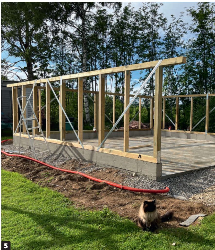
5 Rett opp bunnsvillen (A) først. Hvis bunnsvillen er 100 % i vater, er det mye enklere å bygge resten oppå. Etter at den er rettet opp, markerer du hvor stenderne skal stå og plasserer en vinkel ved siden av hver av dem, slik at de enkelt kan rettes opp og skrues på plass. Deretter kan toppsvillen monteres, før veggene til slutt stives opp med vindtrekkbånd.
