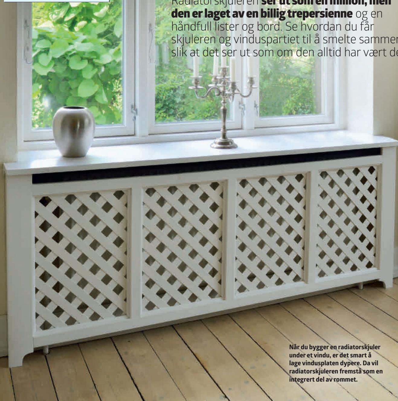
Når du bygger en radiatorskjuler under et vindu, er det smart å lage vindusplaten dypere. Da vil radiatorskjuleren fremstå som en integrert del av rommet.
