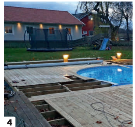
4 Asenna laudat välillä poikittain altaan molemmille puolille. Muuten laudoille on vaikea saada tarpeeksi hyvää tukea.
