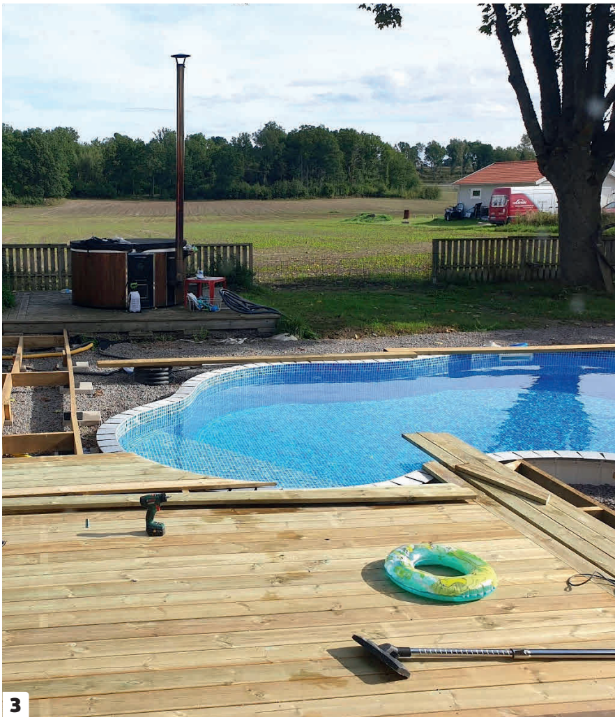
3 Terassilaudat mukailevat altaan aaltoilevaa muotoa. Laudat on helpointa asentaa yliptikinä ja sahata lopuksi pistosahalla. Voit suojata tiivistyskangasta pitämällä terän ja altaan välissä kovalevyä tai peltiä. Muista olla joka tapauksessa varovainen!
