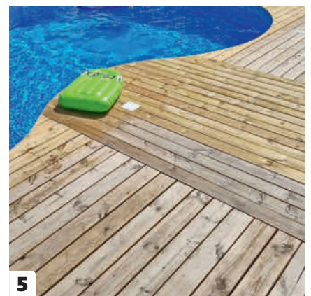
5 Hio reuna joka puolelta. Sahatut reunat kannattaa maalata tai peittää listalla myös siinä tapauksessa, että terassia ei pinta-käsitellä.
