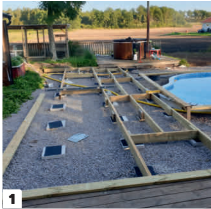
1 Terassin runko tehdään 45x145 millin kestopuulankuista. Runko rakennetaan 30x30 sentin laattojen varaan, jotka ovat tukevasti pikkukivien päällä.
