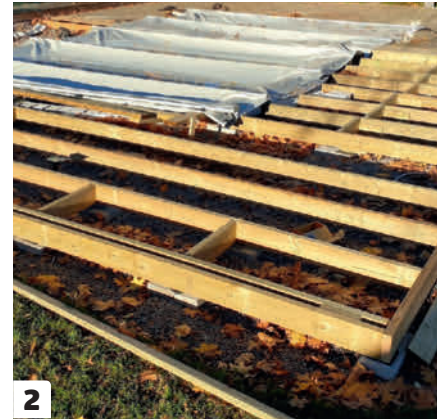
2 Reunoille asennetaan tuplalankut , jotta reunalaudat voi ruuvata tukevasti kiinni.
