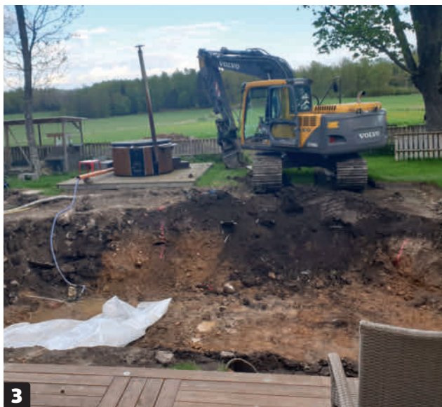
4 Hur besvärlig grävprocessen blir beror mycket på markförhållandena. Det är skillnad på om jorden är mycket sandig och lös eller om jorden är kompakt och lerig, eller om det kanske döljer sig stenar i marken.
