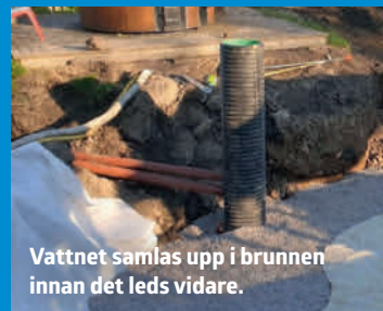
4 Hur besvärlig grävprocessen blir beror mycket på markförhållandena. Det är skillnad på om jorden är mycket sandig och lös eller om jorden är kompakt och lerig, eller om det kanske döljer sig stenar i marken.
