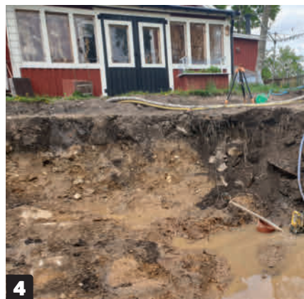
4 Hur besvärlig grävprocessen blir beror mycket på markförhållandena. Det är skillnad på om jorden är mycket sandig och lös eller om jorden är kompakt och lerig, eller om det kanske döljer sig stenar i marken.
