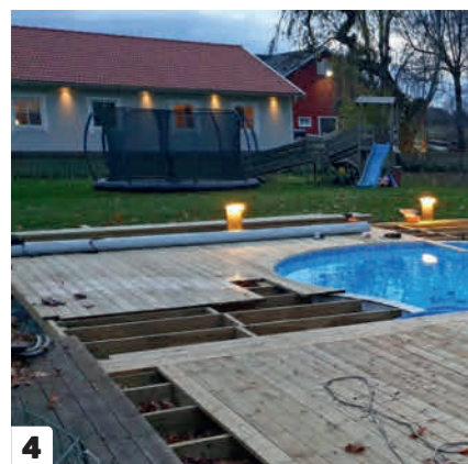
4 Bordene vendes 90 grader midtveis på begge sider av bassenget. Det gjøres for å sikre at det er et underlag for terrassebordene når de skarpe kurvene skal skjæres.
