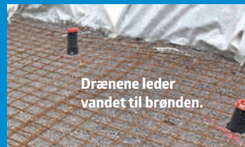
Det opsamlende vand samles i brønden, inden det ledes videre.
