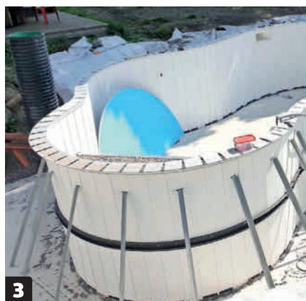
3 På poolens overkant skal der klikkes små aluminiumsvinkler på. De afslutter bassinet og danner underlag for terrassebrædderne senere.
