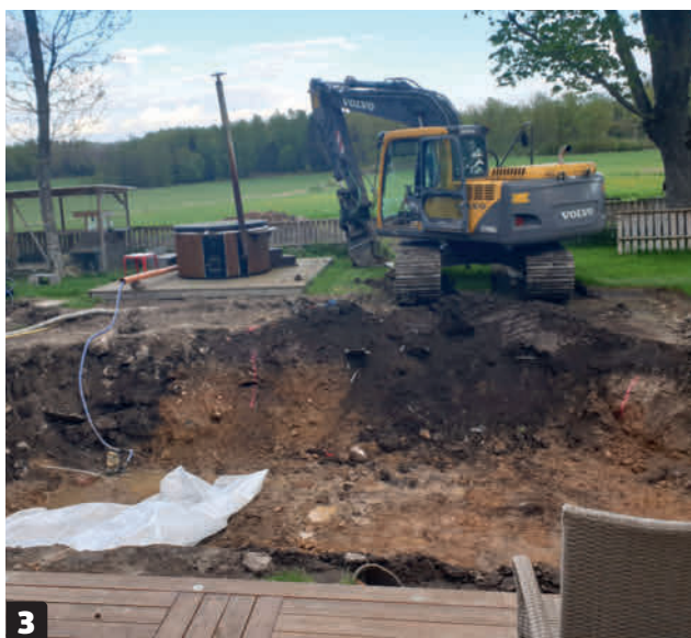
4 Hvor besværlig graveprocessen er, afhænger meget af jordforholdene. Hvis jorden er meget sandet og løs, er det betydeligt sværere, end hvis jorden er kompakt og leret.
