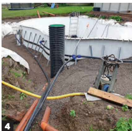
4 I første omgang fyldes der sten på omkring bassinet, så 1/3 er dækket. Dyser, skimmer og diverse slanger tilsluttes også nu, mens der er plads til det.
