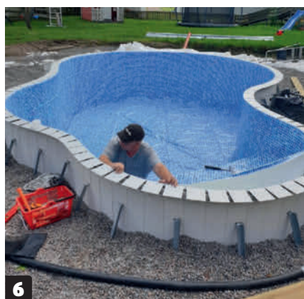
6 “Lineren” er den dug, der afslutter bassinet indvendigt. Den skal være helt tæt, så det er vigtigt, at du støvsuger indersiden af bassinet grundigt for skidt, skarpe småsten og lign., inden du monterer den.
