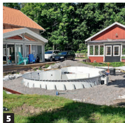
5 Endnu et lag sten fyldes på. Denne gang er det 2/3 af bassinet, der er dækket. Stene danner samtidig underlag for terrassen, som skal omkranse poolen.
