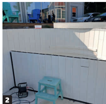
2 I den ene ende af poolen laves der et repos, hvor bunden er hævet. Modellen her er produceret, så det er nemt at etablere.
