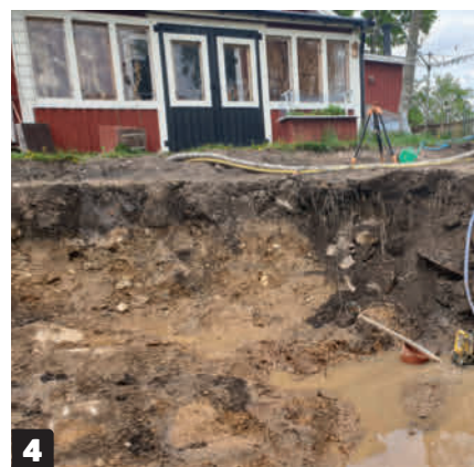
2 Når det øverste muldlag er gravet af, skal skabelonen bruges igen. Lav en opstregning, som er ca. en meter større end selve skabelonen, med markeringsspray.
