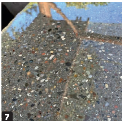
7 Pöytälevy valetaan 0–16 millin kokoisista kivistä ja sementistä. Levyt kiillotetaan tasaisiksi timanttihiomakoneella ja kulmahiomakoneella. Kiillotus saa pinnan näyttämään mosaiikkibetonilta.
