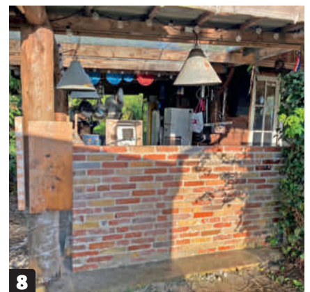
8 Keittiölle rakennetaan katto. Se tehdään poimulevyistä ja pleksistä 45x45 millin ruoteiden päälle. Rimat ovat 90x45 millin lankkujen varassa, joiden alla on jykävät puutolpat ja hirret.
