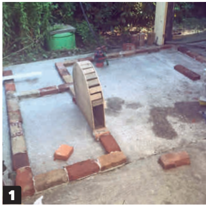
1 Aluksi valetaan 10 senttiä paksu betonilaatta. Alimmat tiilet muurataan kiinni kalkkilaastilla sen jälkeen, kun niistä on tehty koeladonta. Tiilien suoruus ja korko tarkistetaan ennen muuraamista.
