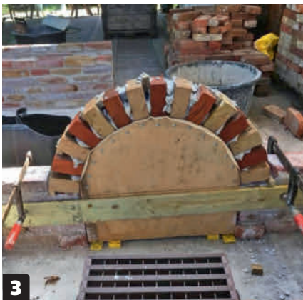
3 Muurauksen jälkeen vaikutuksen. Keittiö on suorassa, ja pöytälevyn alle on tehty kaareva aukko yksinkertaisen vanerisapluunan avulla.
