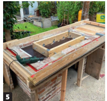
5 Pöytälevy on valettu paikalleen. Muotti on rakennettu ilman kokonaista pohjalevyä. Pohja ja reunat on tehty useista paloista, jotka on asennettu puolen tiilen verran muurin pinnan alapuolelle.
