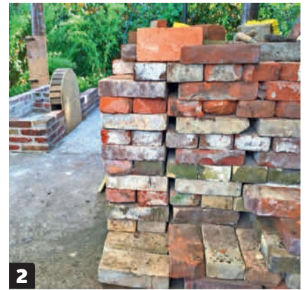
2 Tiilet on lajiteltu kahteen kertaan ja jaettu neljään kasaan, jotta erinäköiset tiilet leviävät tasaisesti eri puolille. Sen jälkeen kasat käytetään yksi kerrallaan muurin tekemiseen.
