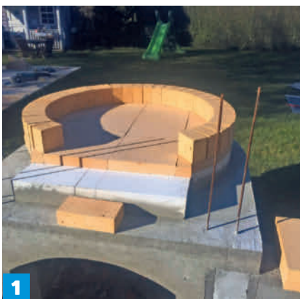
1 Pohjan kolmas ja viimeinen kerros tehdään tulenkestävistä levyistä. Sen jälkeen on aika aloittaa kupolin muuraaminen. Tee koeladonta alimman kerroksen tiilistä, ennen kuin sekoitat laastin.
