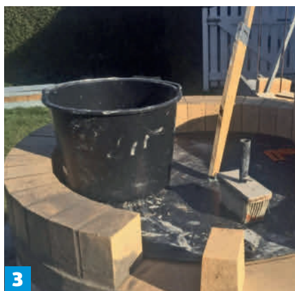
3 Säädä saumojen leveyttä koko ajan. Jos aloitat muuraamisen toisesta reunasta ja jatkat koko ajan yhtä leveällä saumalla, toiseen päähän saattaa jäädä kapea tiili-suikale tai liian leveä laastisauma.
