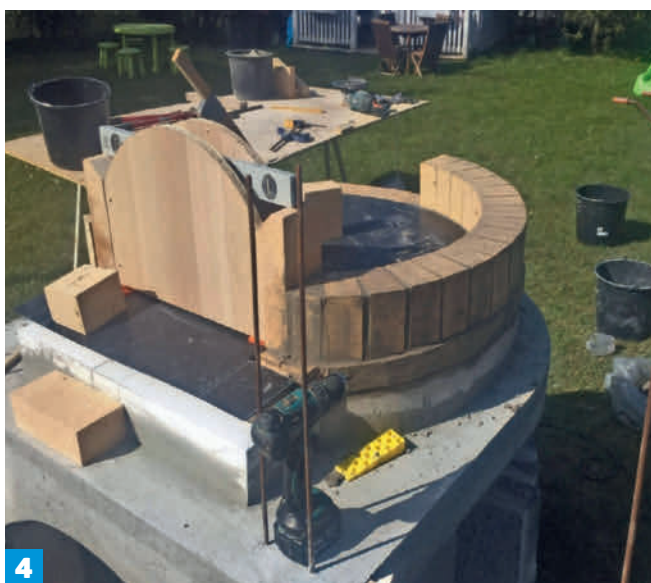
3 Säädä saumojen leveyttä koko ajan. Jos aloitat muuraamisen toisesta reunasta ja jatkat koko ajan yhtä leveällä saumalla, toiseen päähän saattaa jäädä kapea tiili-suikale tai liian leveä laastisauma.
