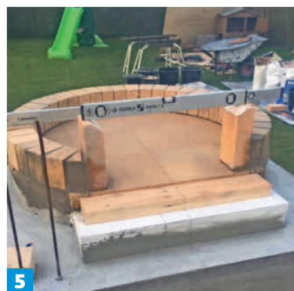
Kun alimmat tiilet ovat paikoillaan ja yhtä korkealla, voit nostaa sapluunan pois tieltä.
