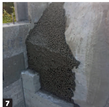
7 Större hålrum kan fyllas ut och formas med en blandning av lecakulor, cement och vatten. Det är lättarbetat och har samtidigt en isolerande effekt.
