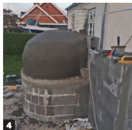
4 Putsa kupolen med ett lager eldfast murbruk på ca 5-8 cm. Gör det så jämnt och runt som möjligt.
