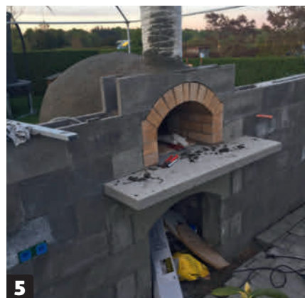
5 Lämuren av skalblock fortsätter över förkammarens valv. Rundningen i blocken kan du göra med en liten vinkelslip.
