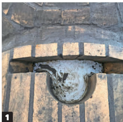
1 Hålet till skorstenen görs precis bakom förkammaren. En hålsåg för sten används för att borra när murverket är torrt.
