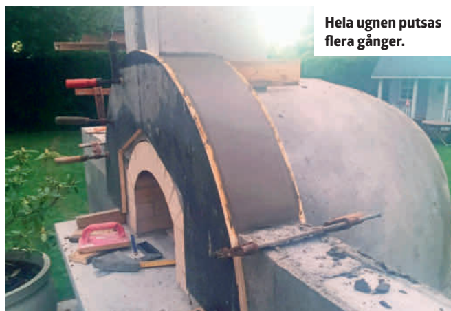
Kupolen muras upp av eldfast tegel, där varje sten har sågats till.
