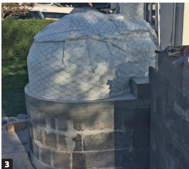
4 Putsa kupolen med ett lager eldfast murbruk på ca 5-8 cm. Gör det så jämnt och runt som möjligt.
