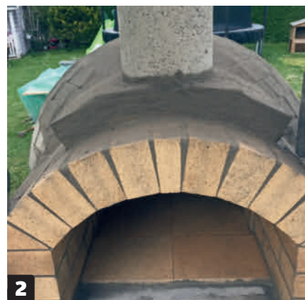
2 Hela den nedersta delen som skorstenen monteras i, ska också putsas. Det lönar sig att vara noggrann med isoleringen hela vägen runt så att ingen värme läcker ut.
