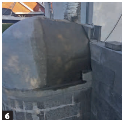
6 Kupolens rundning ska jämnas till med flera lager puts. På så sätt kan formen anpassas till förkammaren och stödmuren.
