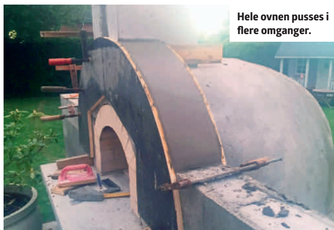
Kuppelen mures opp av ildfaste steiner, der hver og en er skåret til.
