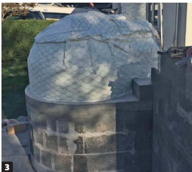
4 Puds kuplen med et lag ildfast mørtelpuds på ca. 5-8 cm. Lav det så jævnt og rundt som muligt.
