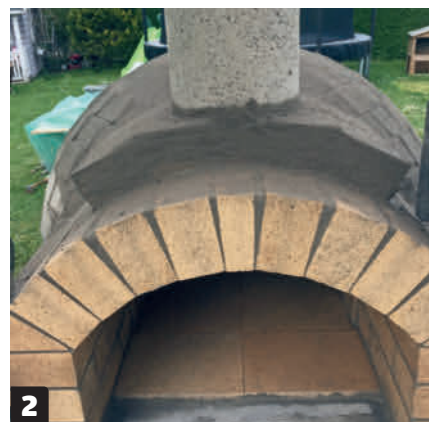
2 Hele den nederste del , som skorstenen monteres i, skal også pudses. Det kan godt svare sig at være grundig med isoleringen hele vejen rundt, så der ikke slipper varme ud.
