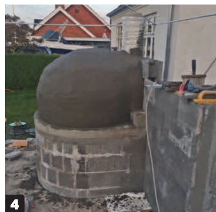
4 Puds kuplen med et lag ildfast mørtelpuds på ca. 5-8 cm. Lav det så jævnt og rundt som muligt.
