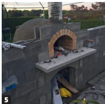
5 Læmuren af fundablokke fortsættes hen over forkammerets bue. Rundingen i blokkene kan du lave med en lille vinkelsliber.
