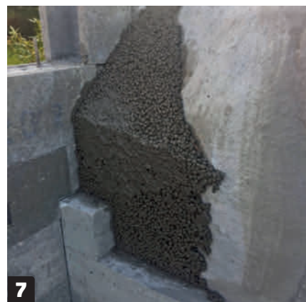
7 Større hulrum kan fyldes ud og formes med en blanding af lecanødder, cement og vand. Det er nemt at arbejde med og har samtidig en isolerende effekt.
