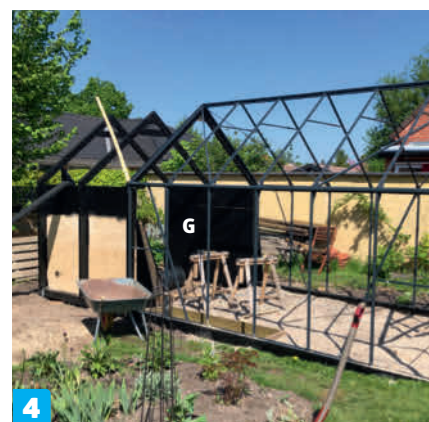
4 Innsiden av tilbygget kles med 15 mm kryssfinér (G), som males svart på begge sider. Sperrene males også i samme omgang, før det legges på tak.
