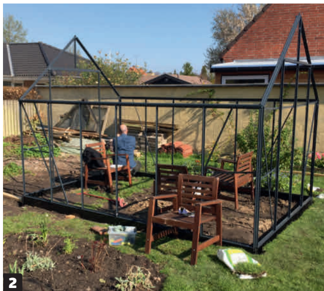
Når rammen er rettet op, kan hele drivhuset samles oven på. Det er dog en god idé at vente med at montere glas-set, til alt belægningsarbejdet indenfor er færdigt.
