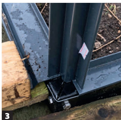
Den medfølgende bundramme samles med beslag, og oven på monteres der en aluvandnæse, som leder vandet væk. Hvis ikke bundrammen medfølger, kan du nemt lave din egen af trykimprægnede reglar.
