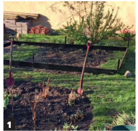
Til drivhuset medfølger en bundramme i aluminium, som rettes op og sættes i vinkel ved hjælp af seks punktfundamenter.
