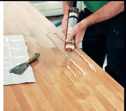
**4 Monter alukraftfolie på undersiden av benkeplaten hvis du har oppvaskmaskin. Legg kun på stykket over oppvaskemaskinen, slik at benkeplaten skånes mot den varme dampen som stiger opp når du åpner maskinen.**
