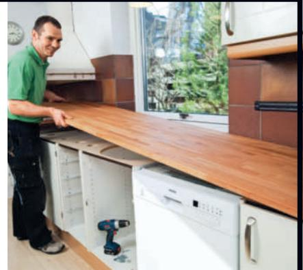
**1 Legg den nye benkeplaten på plass.** Massive benkeplater er tunge, så det er en god idé å få med en hjelpende hånd, slik at platen ikke skades. Forstørrelt hullet i toppaten av skapet hvis den nye vasken er større enn den gamle.
