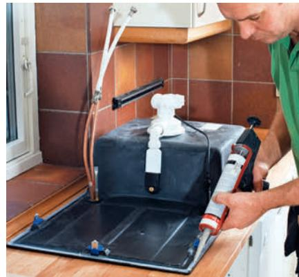
**2 Smør silikon rundt i kanten av vasken.** Silikonen tetter igjen for vannet helt ut til kanten, slik at benkeplaten ikke står og suger vann.
