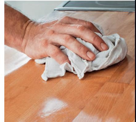
**5 Olje til slutt benkeplaten igjen**, slik at treet er ordentlig godt mettet. Fordel oljen med den myke siden av en grytesvamp, og masser oljen godt inn i treet med en bomullsklut. Fjern til slutt all overskytende olje.
