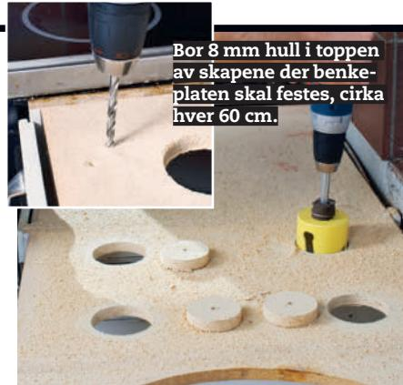
**3 Bor hull i topplatene til kjøkken-skapene hvis de er av typen med hel topplate, slik at platen kan puste. Skal platen heves, kan det gjøres med 3 mm masonitt-strimler. De plasseres løst på skapene der skapsidene møtes.**
