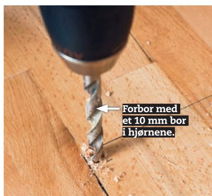
**4 Forbor i hjørnene til utskjæringen av vasken.** Når du borer i hjørnene lager du plass, slik at du kan komme til for å sage ut hullet med stikksagen.
