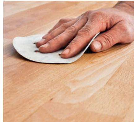
**4 Benkeplaten skal nå ha en omgang olje og en mellomsliping** når oljen er herdet. Mellomslipingen gjør at benkeplaten blir ekstra glatt og fin. Bruk veldig fint slipepapir, f.eks. korn 240.
