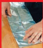
Sett alukraft fast under benkeplaten hvis du skal ha en oppvaskmaskin stående der. Det beskytter mot damp og fukt, slik at platen holder lengre.
