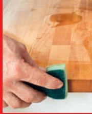
Når du har skjært ut til vasken, er det en god idé å gi benkeplaten en omgang olje rundt kanten på innsiden før vasken monteres. Hvis silikonkanten blir defekt, kan det trenge ned vann, derfor vil treet være mer motstandsdyktig med olje.
