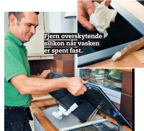
**3 Sett vasken på plass.** Den skrus fast med medfølgende skruer. Du skal ha lagt på så mye silikon at det tyter ut under kanten når du skrur fast vasken. Vær nøy med å fjerne overskytende silikon.
