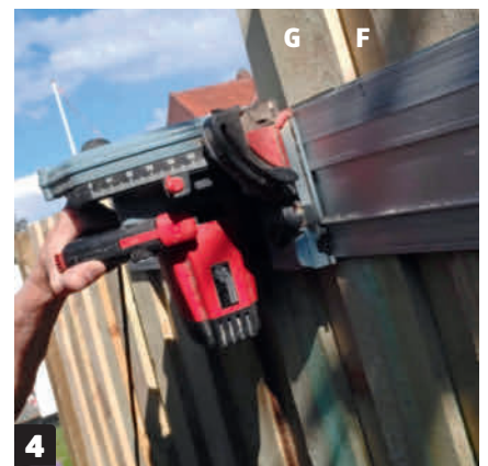
4 Sahaa vuorilaudat (F+G) poikki suorassa linjassa. Tässä käytetään upotussahaa ja ohjajainkiskoa, mutta voit sahata laudat poikki myös käsisirkkelin ja suoran laudan avulla.
