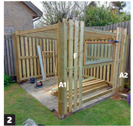
2 Ensimmäisen kerroksen reunimmaisiet laudat (F) tulevat kiinni tolppiin (A1+A2). Jos laudat eivät sovi tolppia vasten kokonaisina, halkaise ne.
