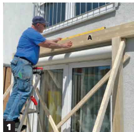
Bärlinan på väggen placeras på en tillfällig ställning. Kontrollera att bärlinan ligger helt rakt.
