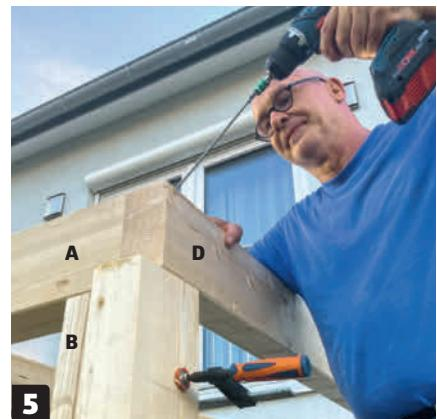
**Skru fast den ytterste sperren (D)** med lange skruer, som skrus inn ovenfra, skrått inn i svillen (A). Sett også inn en skrue fra undersiden.
