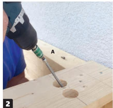
**Sperrene skrus fast** med lange skruer som skrus skrått ned gjennom sperren og inn i svillen. Det er boret hull i hjelpeplaten, slik at det er plass til å sette i skruene. Hjelpeplaten fjernes når sperren er skrudd fast.
