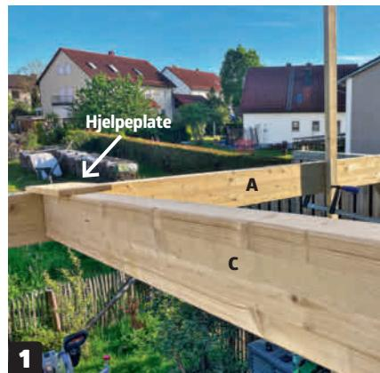
**Monter de midterste sperrene (C).** Sperrene kappes til i endene med et skrått snitt, slik at de kan passe inn mellom svillene (A). Press sperren opp mot en hjelpeplate, slik at det er plass til å sette i skruene. Hjelpeplaten fjernes når sperren er skrudd fast.
